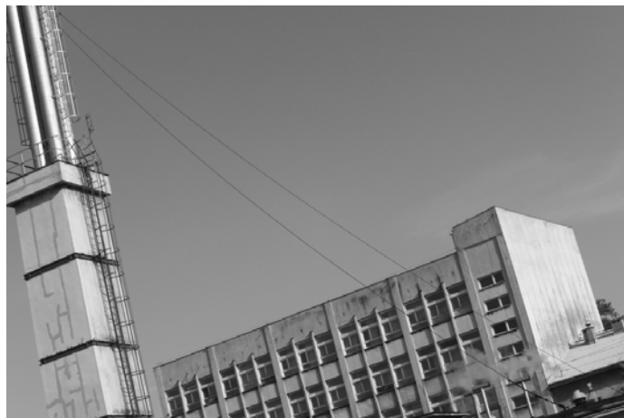
Rys. 7.18. Zarejestrowany kamerą cyfrową Kodak DCS 760 obraz linii wraz z punktami stanowiącymi podstawę przekształcenia rzutowego: dwa - to punkty zaczepienia linii, trzeci – to sygnał na statywie, czwarty został zaznaczony na trzonie komina
